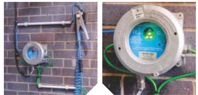
Figura 2: Dispositivos de aterramento estático com referências visuais para operadores e motoristas, com circuitos de monitoramento de loops de aterramento que estão em conformidade com as normas IEC 60079-23, NFPA 77 e API RP 2003.
