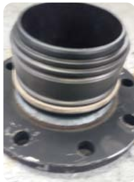
Foto 8. Envuelva el guardapolvo con firmeza en la junta macho.
