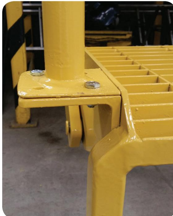
Foto 5. Zapata fijada por cuatro tornillos.
