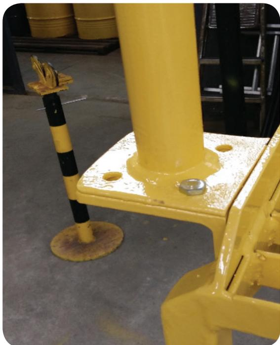
Foto 4. Zapata de la baranda fijada a la base.
