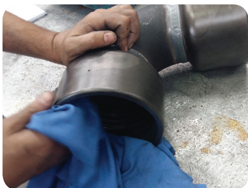
Foto 1. Limpie internamente el alojamiento de la junta hembra.
