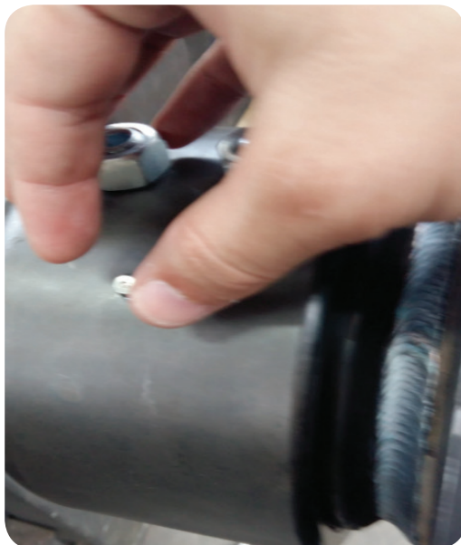
Foto 15. Coloque la engrasadora en el orificio.
