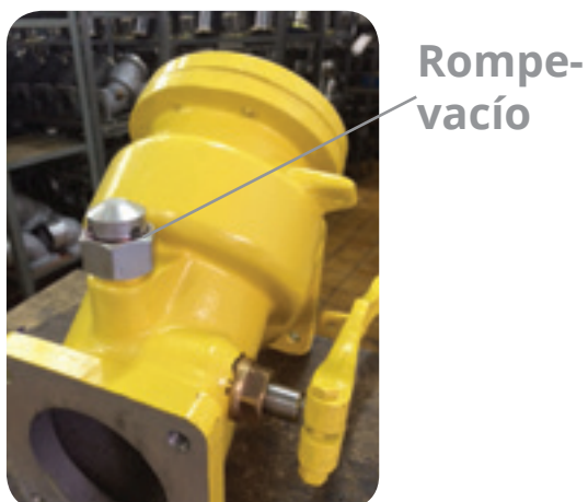
Foto 19. Válvula rompe-vacío instalada.
